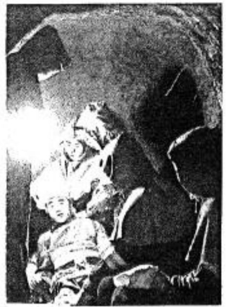
防空壕 空襲のときに避難するため、地を掘って作った穴。
